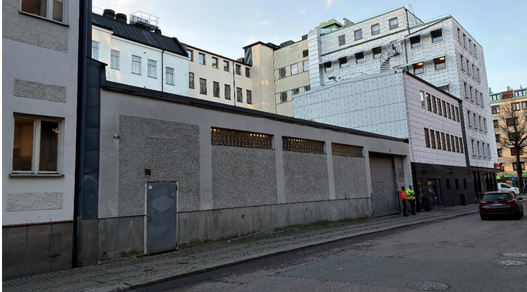
Foto på befintlig byggnad mot Lorensbergsgatan inom Lorensberg 53:3
