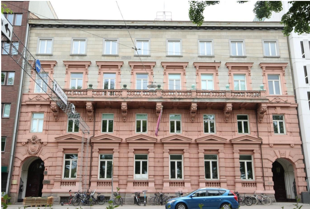
Foto på befintlig byggnad inom Lorensberg 55:3 sett från Södra vägen
