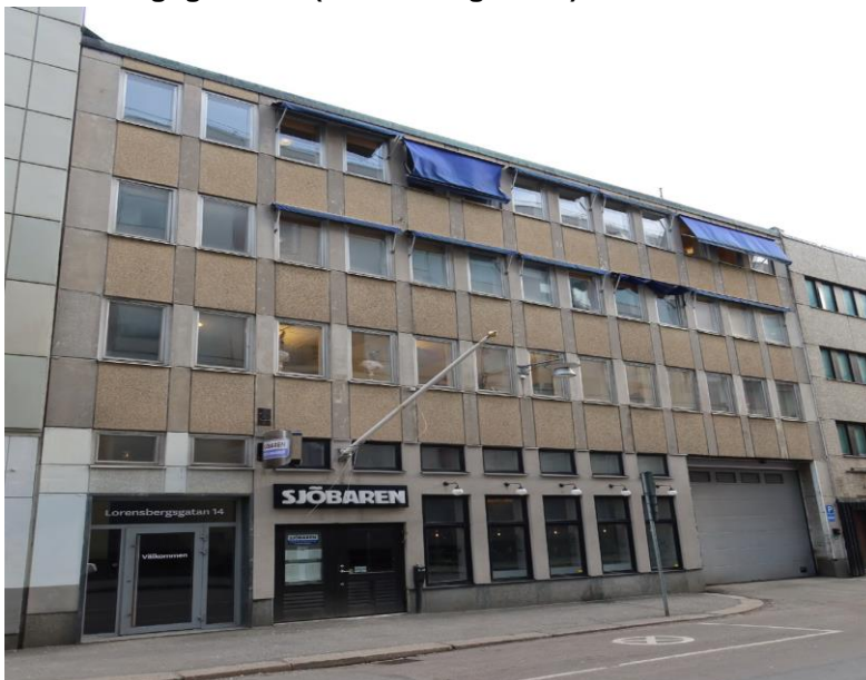
Foto på befintlig byggnad inom Lorensberg 55:15 mot Lorensbergsgatan
