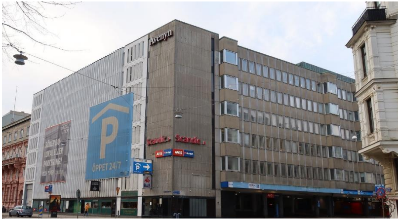
Foto på befintlig byggnad inom Lorensberg 55:15 mot Södra vägen
